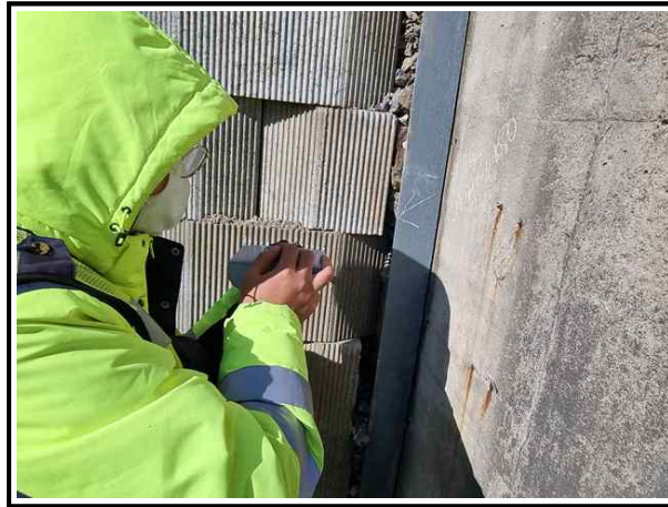
【그림 4.3.6】 슈미트해머를 이용한 반발경도시험 전경
